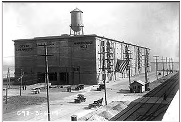
Warehouse No. 1, 1917 (Queenan 1983).
