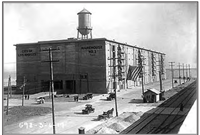
Warehouse No. 1, 1917 (Queenan 1983).
