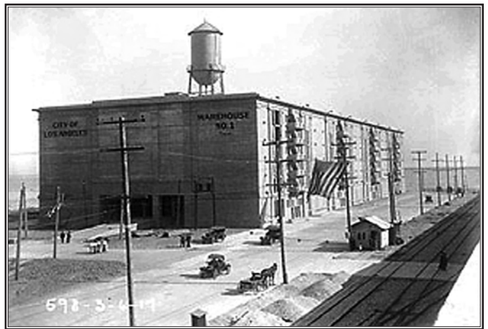
Warehouse No. 1, 1917 (Queenan 1983).
